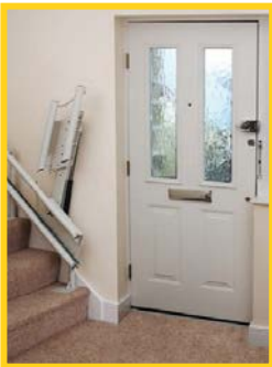
Akkubetriebene Schiene "angehoben"
